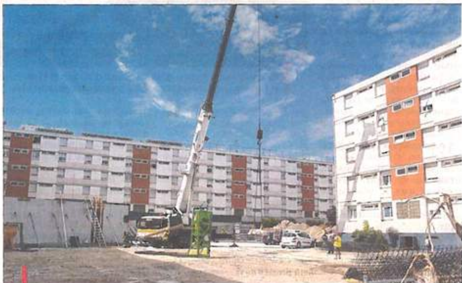
Ici la dalle de béton a été cassée. L'esplanade va se transformer en espace vert, plus apaisant. / Pic.C.M.S.
