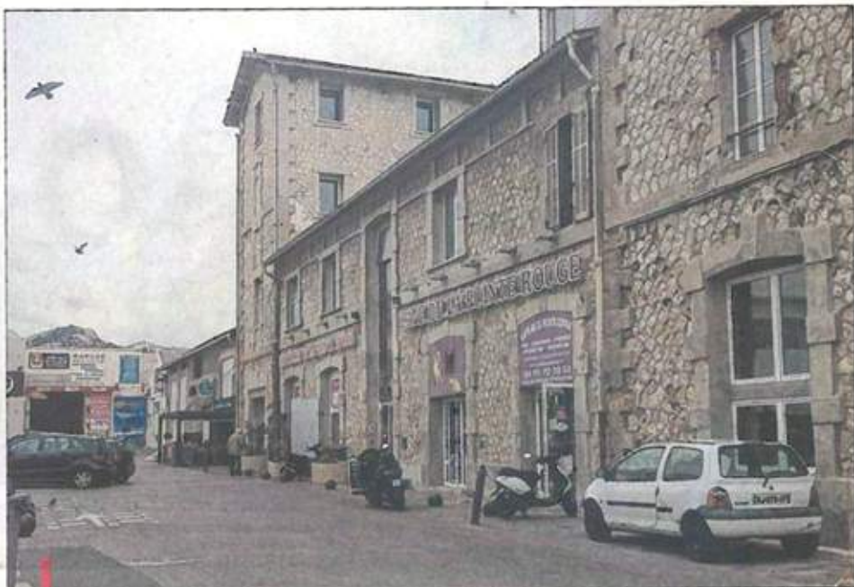
Les hangars situés en fond d'îlot, derrière le supermarché Lidl et le Nautica, au 83, avenue de la Pointe-Rouge doivent être remplacés par des logements et une résidence seniors contestés. / PHOTOS A.S.
