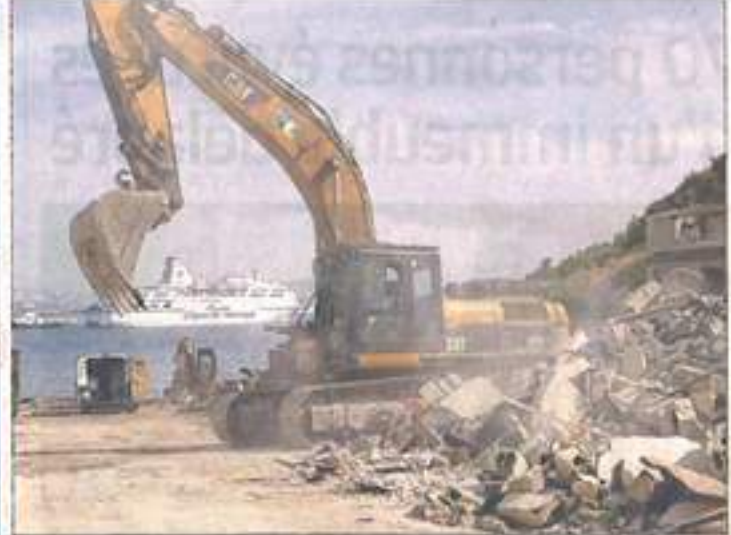
Photo centrale: vue du site au début des démolitions, en juillet dernier. À droite, pelleteuse au travail sur la dalle de 5 000 m 2 qui devrait être conservée. Des tonnes de gravats doivent être évacuées.
