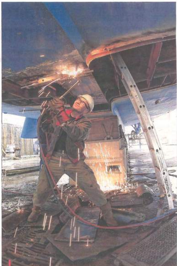
Opération de chaudronnerie sous la coque de "Montkaj", mis au sec en forme n°1. / PHOTOS FREDERIC SPOHN
