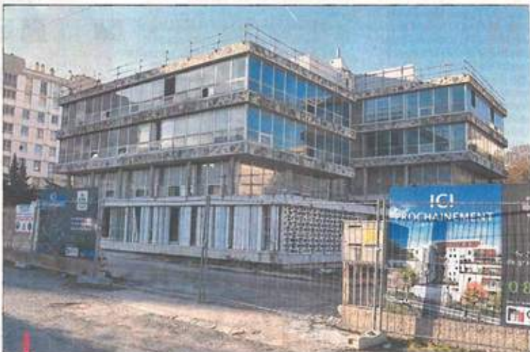
Les travaux de démolition préalable à la future construction d'une résidence de 23 mètres de haut ont été lancés au 14 boulevard du Commandeur (9 e ), au grand dam de 19 de ses riverains... / PHOTOS C.T.
