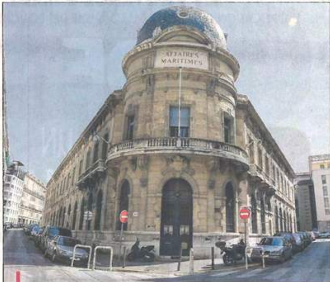
L'ancien Hôtel de la Marine, à la Joliette, devrait quitter le giron de l'institution départementale, qui ne lui a pas trouvé d'utilité. Un nouvel appel d'offres vient d'être lancé.
