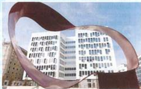
Astrolabe, premier bâtiment du quartier Euroméditerranée.
