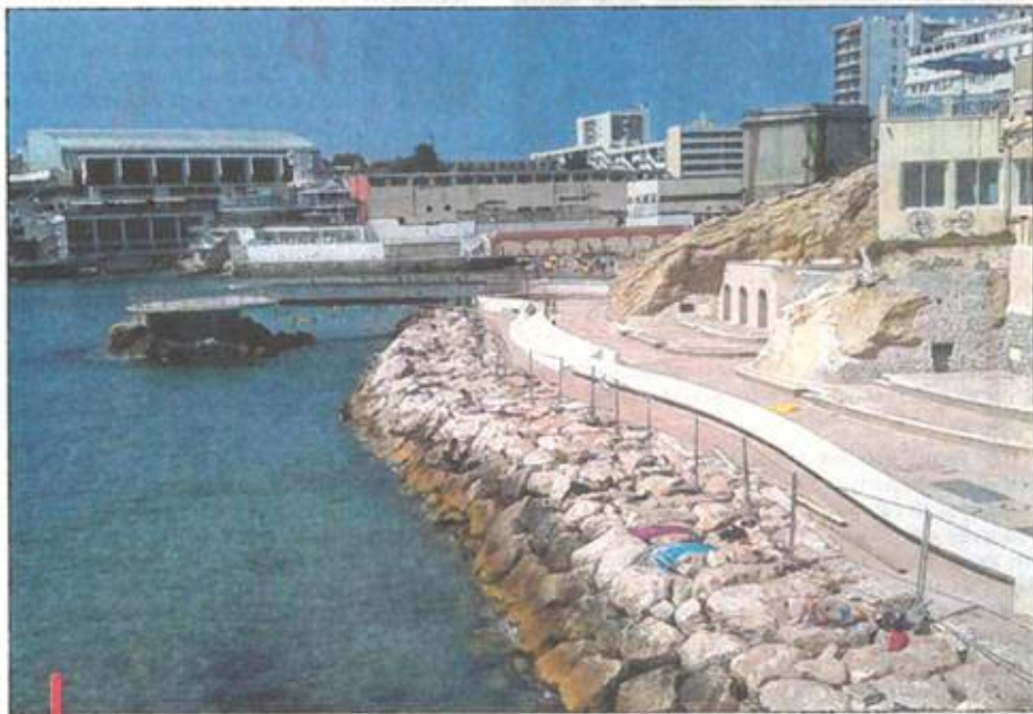
Sur la partie sud, le chantier de semi-privatisation correspondant à 20% de la plage des Catalans est en cours. Les piétons pourront déambuler sur le nouvel espace créé, d'ici 2016. / PHOTO LP
