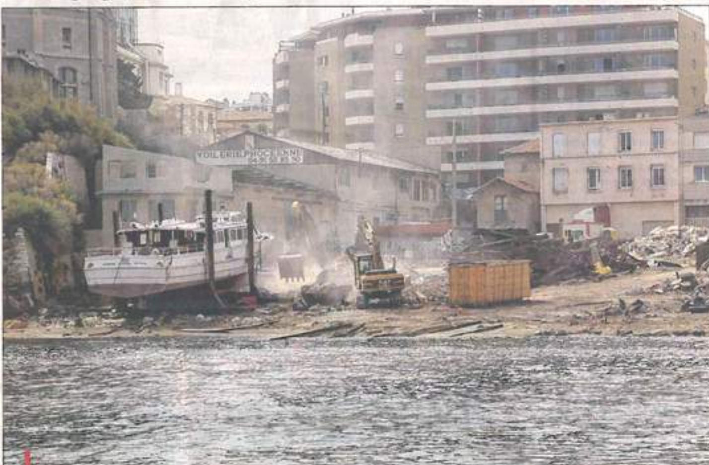
À défaut de quiétude en raison du bruit des travaux, les riverains ont retrouvé une vue imprenable sur la rade Nord. / PHOTOS VALÉRIE VREL
